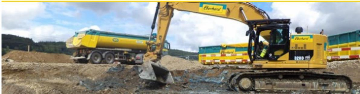
**In Untersiggenthal saniert die Eberhard Recycling AG zurzeit die Deponie Schiffmühle Süd. Rund 10 000 t Material müssen ausgehoben, triagiert und fachgerecht entsorgt werden. Zwischen 1952 und 1972 wurden in dieser Deponie verschiedene Gruppen von Produktionsabfällen aus der Chemieindustrie abgelagert. Auslöser für die Sanierung der Deponie waren die erhöhten Chromat-Messungen im Grundwasserstrom.**
