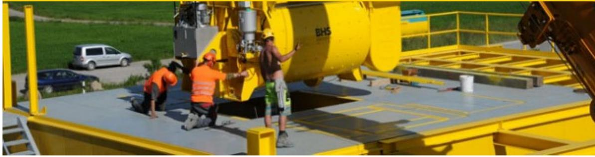
Am 5. Juni brachte ein Schwertransport den neuen, 5 m<sup>3</sup> Festbeton fassenden Doppelwellen-Chargenmischer von BHS nach Rümlang. Trotz einer Höhenbeschränkung von 17 m konnte der Mobilkran kurz vor 18.00 Uhr den Mischer auf die Stahlkonstruktion hieven.
