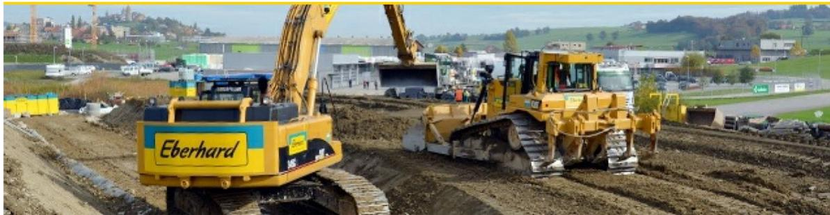
Während der Bauarbeiten für ein neues Produktions- und Verteilzentrum im Welschland saniert die Ebiox AG rund 7200 m<sup>3</sup> kontaminiertes Aushubmaterial. Zur Anwendung kommt das hierfür bewährte VacHeap-Verfahren, das sich biologische und physikalische Bodeneigenschaften zunutze macht.
