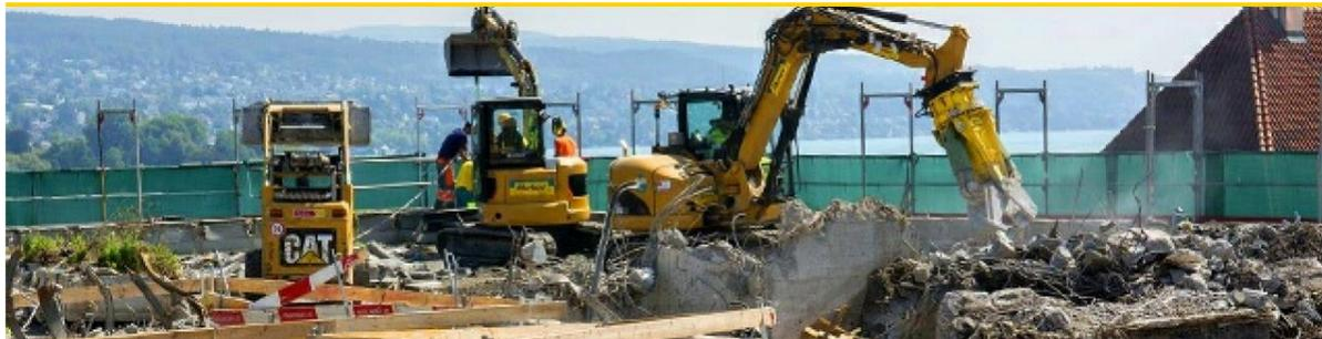
Am 4. Februar 2013 konnte die Eberhard Bau AG im Auftrag der Schweizerischen Rückversicherungsgesellschaft AG mit der Schadstoffsanierung und dem Rückbau des Gebäudes beginnen. Zum 150. Geburtstag von Swiss Re am 18. Dezember 2013 ist der Rückbau der sieben Obergeschosse am Mythenquai 50 in Zürich abgeschlossen.
