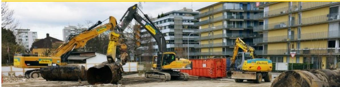
**Die Skyline von Oerlikon erhält Zuwachs, an der Neunbrunnenstrasse entsteht der 50 m hohe Osterwalder Tower. Seit den 70er Jahren hat die Firma Osterwalder an diesem Standort Heizöl, Diesel und Benzin umgeschlagen. Es sind deshalb neben dem Rückbau des Bürogebäudes auch noch 19 erdverlegte Tanks zu entsorgen.**
