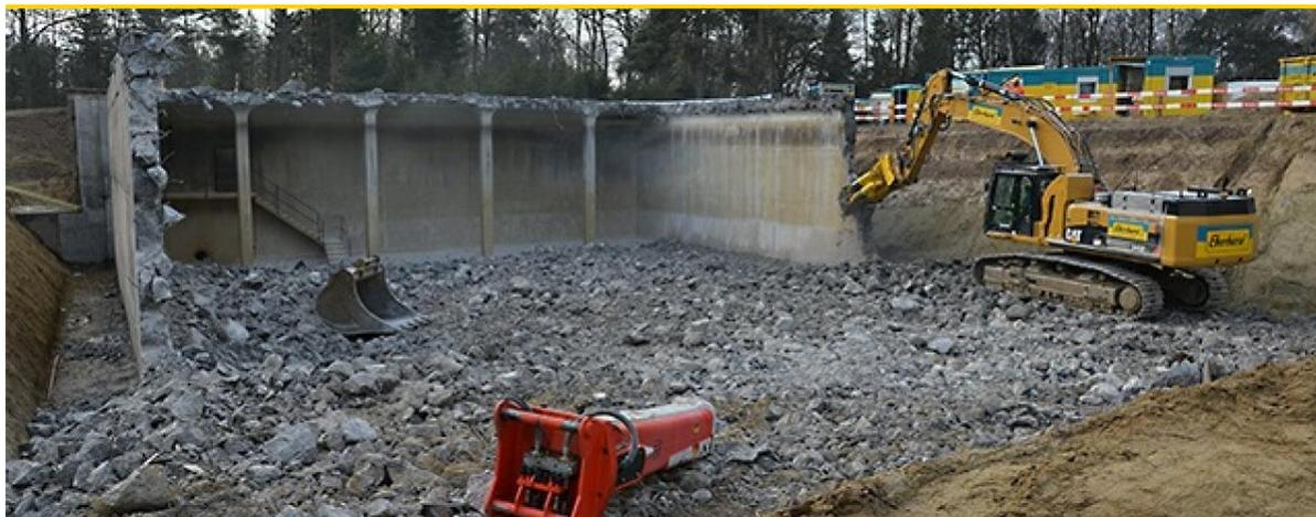
**Ein Neubau soll bis 2018 das 80 Jahre alte Wasserreservoir Käferberg in Zürich ersetzen. Behälter I und II bleiben vorläufig in Betrieb, Nummer III wird aktuell rückgebaut.**
