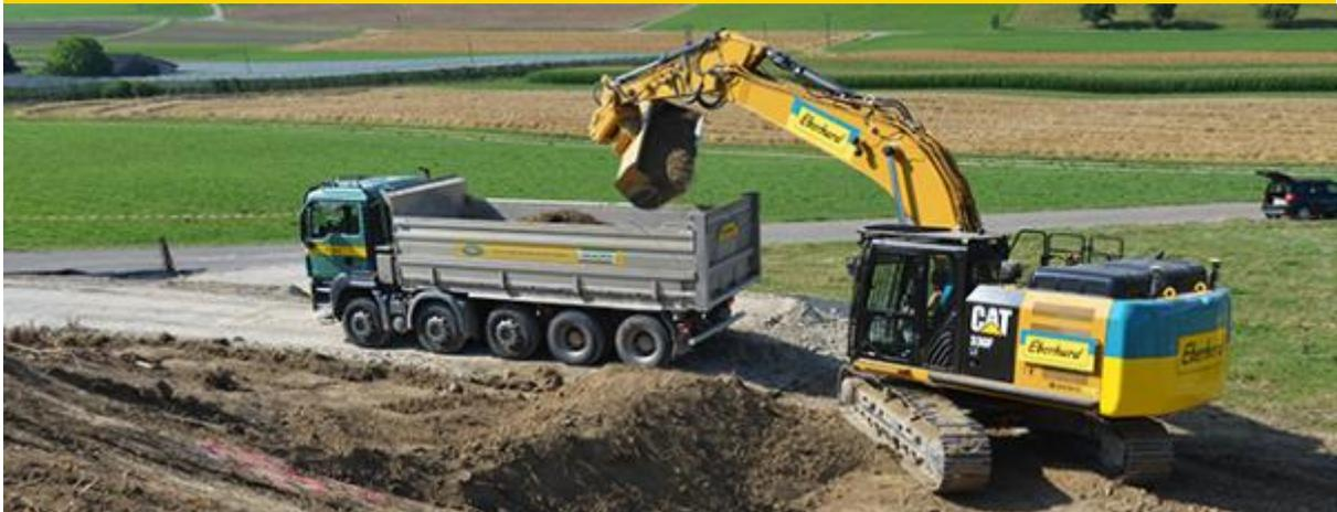
**Bei der Sanierung eines Kugelfangs in Freienstein kümmerten sich die Eberhard Unternehmungen um die ganze Entsorgungskette – Abtrag, Transport und Verwertung des belasteten Materials.**
